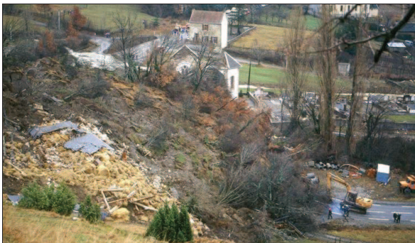
Depuis le mercredi 5 janvier 1994, des pluies abondantes s'étaient abattues sur le village. Le samedi 8 janvier, le glissement de terrain a recouvert la route nationale 85 sur plus de 100 mètres. Photos Le DL/Archives
